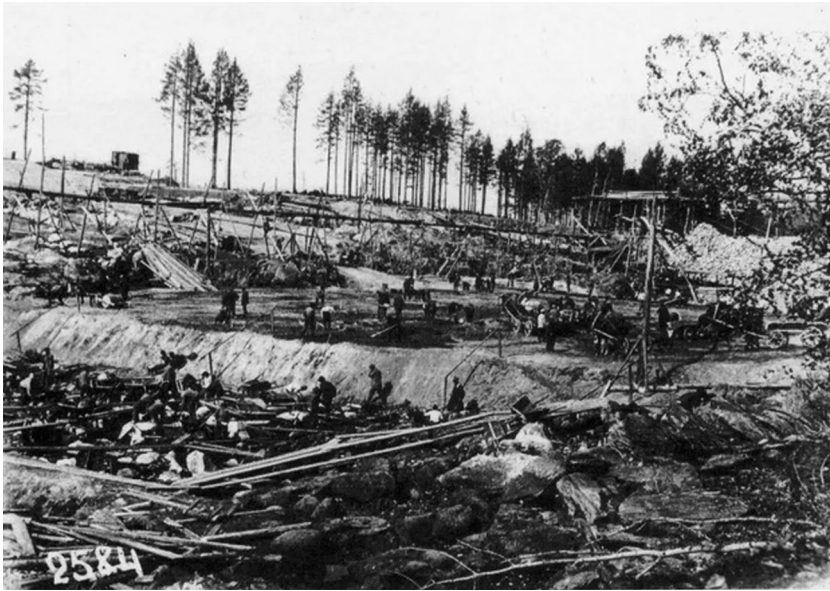
Строительство Беломорско-Балтийского канала заключенными Белбалтлага, где отбывал наказание А. Ф. Лосев, 1933 г.
