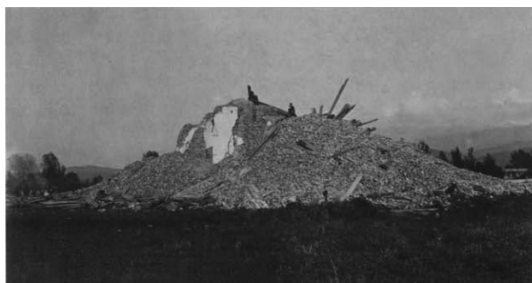
Илл. 5а. Покровская церковь в разрушенном виде. 1887 г.: «Превратилась в груду кирпичей».
