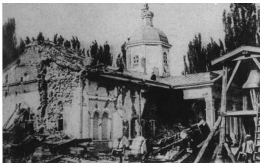
Илл. 1а. В разрушенном виде. 1887 г.
