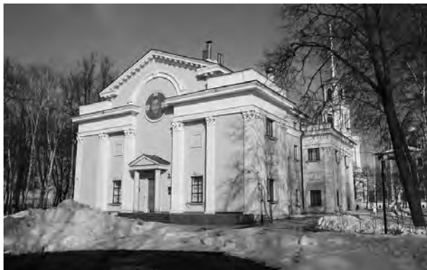
Здание Рязанского епархиального управления (настоящее время)
